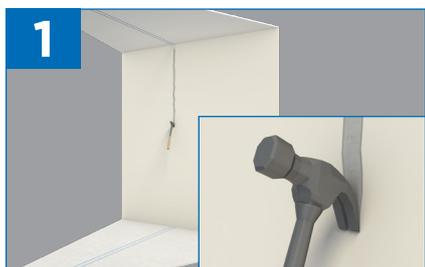
Tracez au sol, au mur et au plafond l'emplacement de la verrière/muret. Pour une bonne adhérence des carreaux de plâtre sur les murs existants, piquez préalablement les surfaces à l'aide d'un pic ou d'un marteau.
