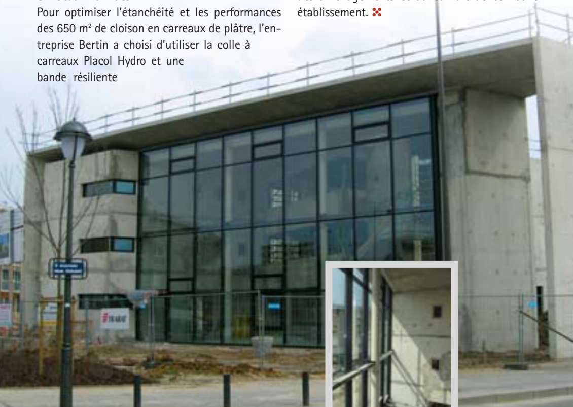
Vue extérieure du chantier maison de retraite EHPAD
