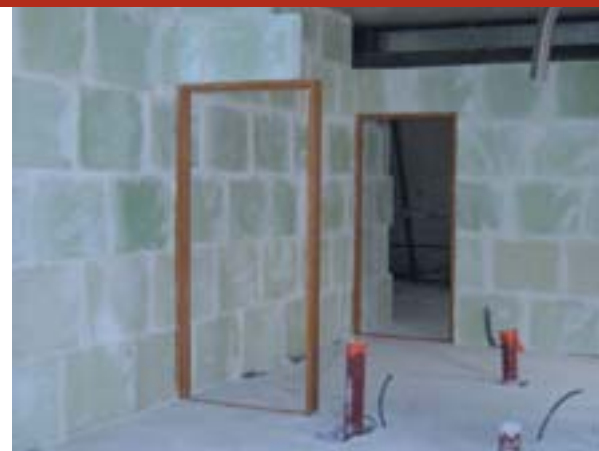
Cloisons maçonnées en Caroplatre® Superhydro® THD 7 cm
