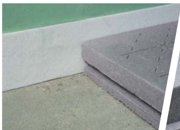
▲ Stisol® rouleau en périphérie des parois verticales, canalisations, huisseries...
