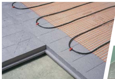
▲ Plancher rayonnant électrique
