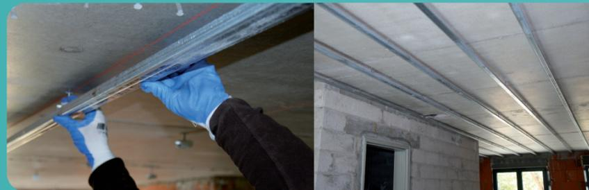
> Sur ossature métallique Placostil<sup>®</sup> (fourrure ou montant) à entraxe de 500 ou 600 mm.
