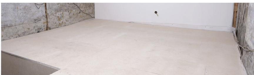
**6.1** Respecter un temps de durcissement de la colle de 12 heures avant de commencer la pose du revêtement final. Découper la bande de désolidarisation Stisol® Rouleau qui dépasse du niveau fini de la chape sèche Rigidur® Sol.
