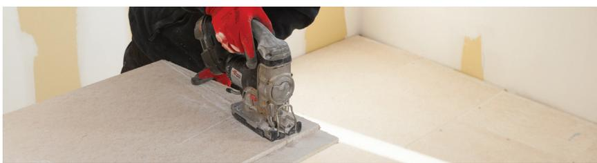
**3.1** Commencer la pose des plaques en respectant le plan de calepinage et en fonction de l'utilisation de Placoforme® ou non. Scier les feuillures supérieures des plaques Rigidur®Sol en contact avec les murs périphériques, afin d'éviter la formation d'un vide (les plaques doivent présenter la même épaisseur en tout point).
