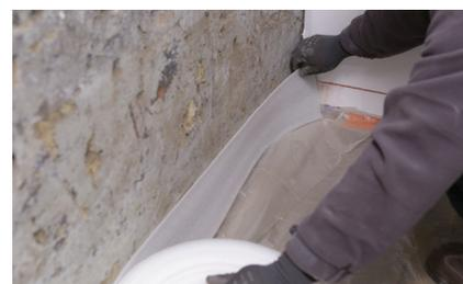
**2.1** Il est recommandé d'installer la bande de désolidarisation Stisol® Rouleau sur l'ensemble des murs périphériques de la pièce. Dans le cas d'un sol déformé, utiliser la granule d'égalisation Placoforme® pour rattraper la planéité du sol. Pour cela, reporter le point le plus haut du sol existant sur les murs périphériques à l'aide d'un niveau. Le niveau fini de la forme d'égalisation se trouvera au minimum à 2 cm au-dessus de ce point.
