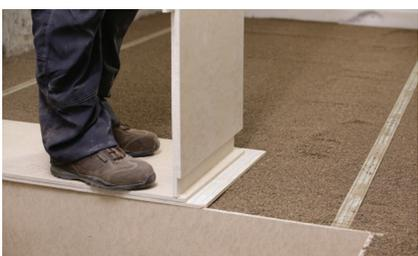
**4.1** Après la pose du premier élément, un double cordon de colle Rigidur® Nature Line est déposé sur la feuillure de la plaque. La plaque suivante y est ensuite collée.
