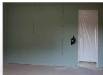
3.1 Finir l'ouvrage de manière traditionnelle. Utiliser une plaque Placomarine® côté garage (local non-chauffé)
