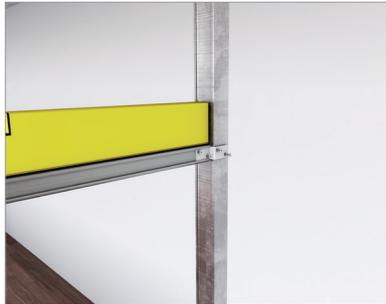
Fixation des équerres entre le rail coulissant et les montants boxés (= montants doubles, emboîtés).
