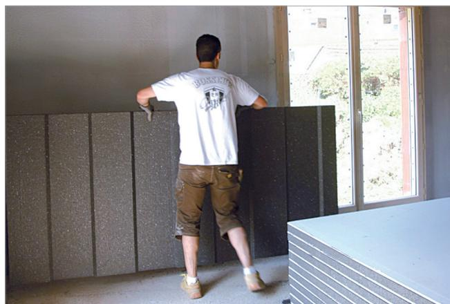
1.2 Poser le panneau contre le mur, les vagues devant être orientées verticalement.
