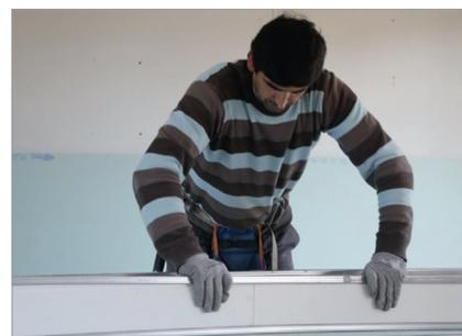
1.1 Encoller les fourrures Up Stil® 269 sur chacun des côtés du bloc PSE Up Stil® (à l'aide d'une mousse PU ou de colle silicone)
