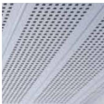
Les ossatures sont constituées de profilés porteurs et d'entretoises en acier galvanisé conformes à la norme NF EN 13964. La mise en œuvre des ossatures doit être conforme au DTU 58.1 (plafonds suspendus).
