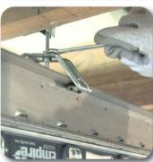
• Régler la hauteur du profilé à l'aide de l'écrou serti dans la suspente Stil Prim® Tech (clé de 11).
