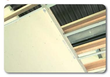
Visser les plaques sur les profilés Stil Prim® Tech et sur l'ossature secondaire au pas de 30 cm (15 cm en cas de montage feu).
