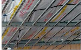
"Nous avons réalisé des plafonds acoustiques de grande portée avec deux parements Placo® Phonique et une laine de verre. C'est idéal pour les plafonds techniques, surtout quand il s'agit d'incorporer des trappes d'accès et des luminaires car nous pouvons régler les entretoises précisément tous les 10 cm. De plus, l'ossature est très rigide, robuste et plus sécurisante dans sa manipulation du fait de la suppression des bords tranchants."
