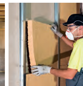
Cloisons séparatives et distributives
