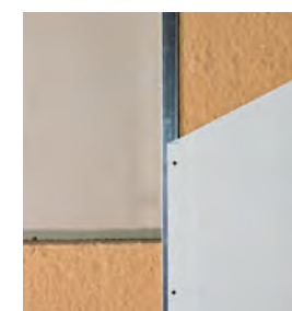
Murs par l'intérieur sous ossature secondaire métallique
