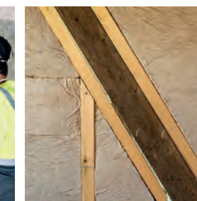
Combles aménagés entre chevrons ou sous-chevrons
