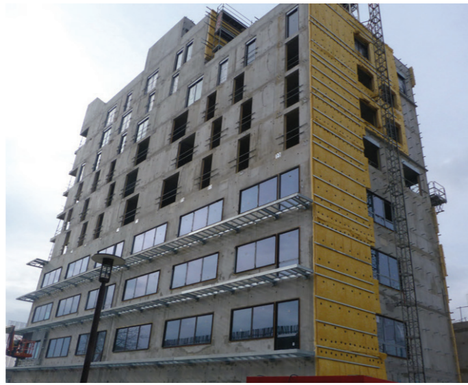
Bâtiments tertiaires et logements Imbrika Nantes - Architectes Brenac et Gonzales.
