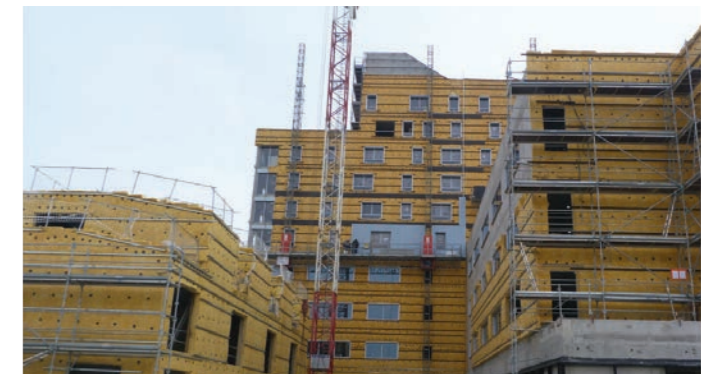
Bâtiments tertiaires et logements Imbrika Nantes - Architectes Brenac et Gonzales
