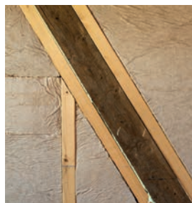
Combles aménagés entre chevrons ou sous-chevrons
