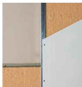
Murs par l'intérieur sous ossature secondaire métallique
