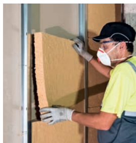
Cloisons séparatives et distributives
