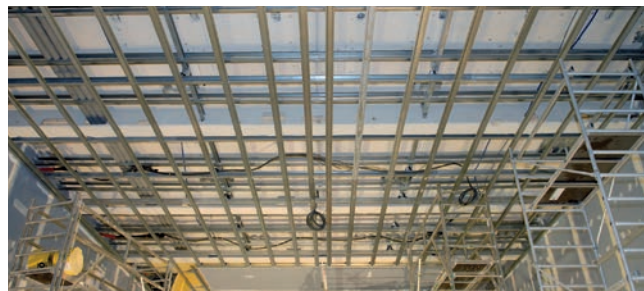
Chantier Canal+ - Plafond Megastil ®
