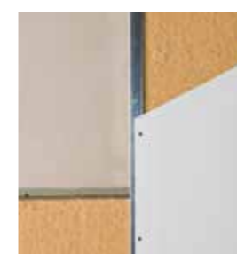
Murs par l'intérieur sous ossature secondaire métallique
