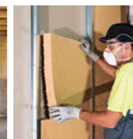
Cloisons séparatives et distributives
