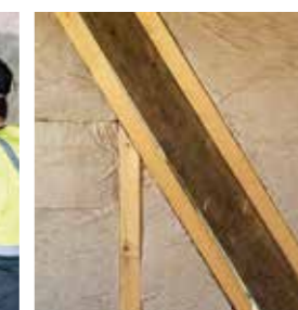
Combles aménagés entre chevrons ou sous-chevrons
