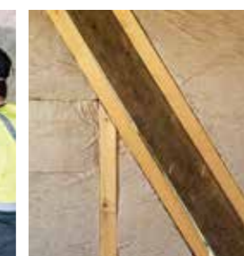
Combles aménagés entre chevrons ou sous-chevrons
