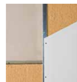
Murs par l'intérieur sous ossature secondaire métallique
