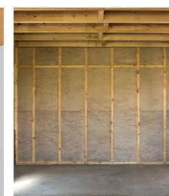
Murs par l'intérieur à ossature bois
