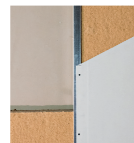
Murs par l'intérieur sous ossature secondaire métallique
