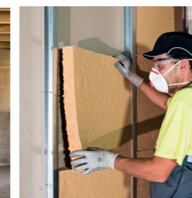
Cloisons séparatives et distributives
