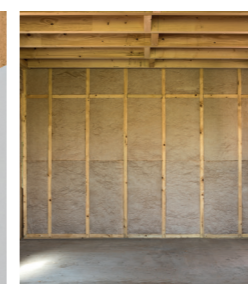
Murs par l'intérieur à ossature bois
