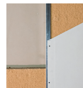
Murs par l'intérieur sous ossature secondaire métallique
