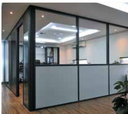
DTU 35.1 Cloisons amovibles et démontables
