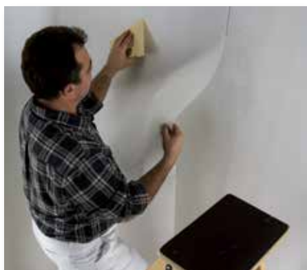
DTU 59.4 Mise en œuvre des papiers peints et des revêtements muraux
