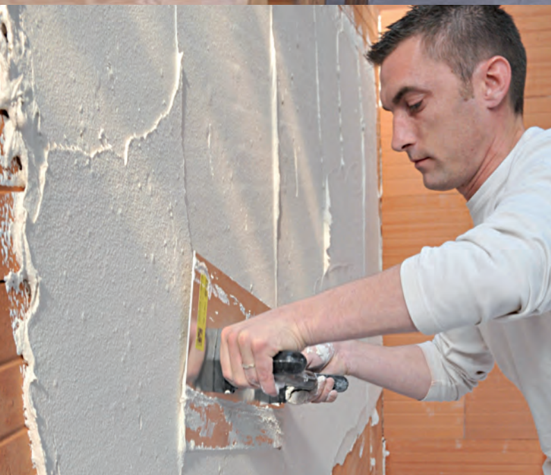
Eglise Luthérienne Exincourt(25) - Entreprise Dufour
