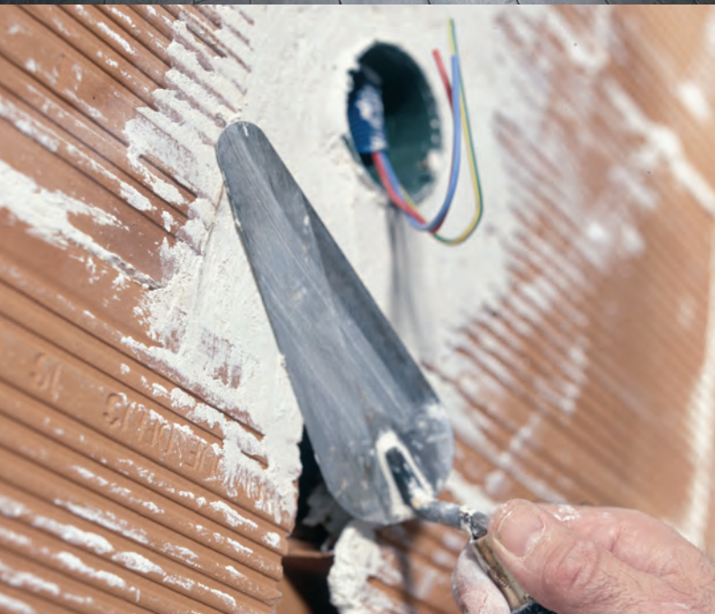
Maison balnéaire (17) Entreprise Douzille
