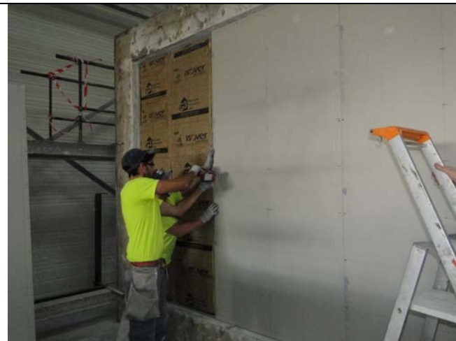
Pose des parements
