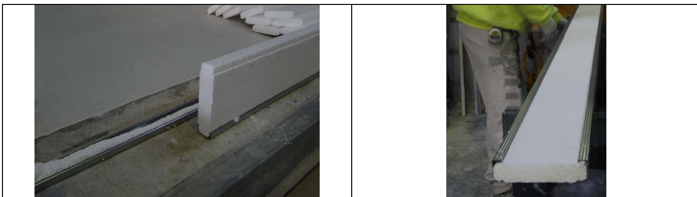
Assemblage des montants
