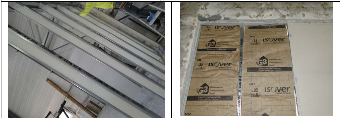
Mise en œuvre de l'ossature
