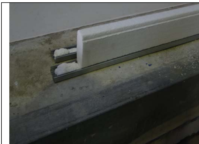
Assemblage des montants
