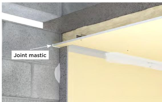
› Traitez la jonction doublage / plafond avec bande à joint et enduit (un joint mastic sera fait au préalable en périphérie du plafond).
