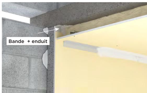
› Traitez la jonction doublage / gros œuvre avec bande à joint et enduit.
