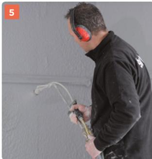
5 **2<sup>e</sup> passe :** Projection de 2 mm environ sur chaque pan de mur (au plus, 30 min après la 1<sup>re</sup> passe).
