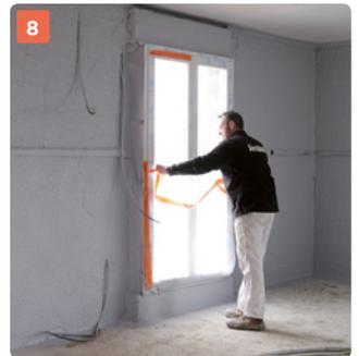
8 Nettoyage du chantier. Pose du doublage possible 48 h après la projection.
