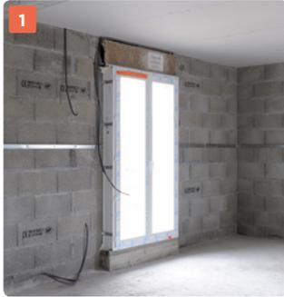
1 Nettoyage de la surface au sol. Bas des murs dépoussiérés sains et secs.
