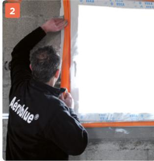
2 Protection des menuiseries extérieures. Utiliser un film plastique de protection « spécial menuiseries » avec bande adhésive. Si les fourrures pour les doublages sur ossature sont déjà posées, les protéger.
