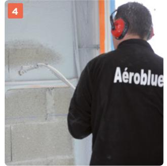
4 **1<sup>re</sup> passe :** Projection de 3 mm d'épaisseur environ par pan de mur. Laisser 15 à 20 minutes avant la 2<sup>e</sup> passe.
