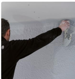
Noyer une bande grillagée en fibre de verre (type Fibatape de chez Adfors) dans le revêtement technique intérieur aux jonctions menuiseries/maçonnerie et plafond/maçonnerie.
