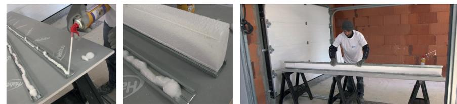
Encoller les fourrures Up Stil® 269 à l'aide d'une mousse PU (1) et clipser les blocs de PSE Up Stil®. L'assemblage des montants au PSE est définitif après 24h de temps de séchage, cependant il est possible de mettre en œuvre la cloison pendant ce laps de temps.
