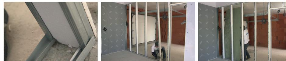
Intégrer les montants isolants assemblés Up Stil® (entre les cornières, au sol puis au plafond) tous les 0,6 m maximum puis les fixer à l'aide d'une vis TRPF 13 de chaque côté de l'ouvrage.
